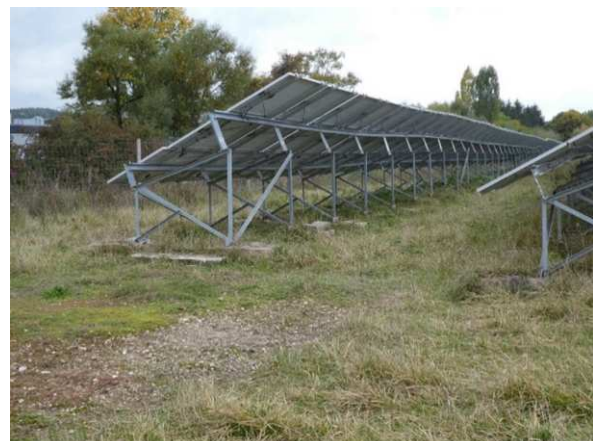
Bild 4 (links): in den Baugrund gerammte Metallprofile als Gründungsmaßnahme für eine PV-Freifieldanlage
