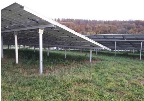
Bild 4 (links): in den Baugrund gerammte Metallprofile als Gründungsmaßnahme für eine PV-Freifieldanlage
